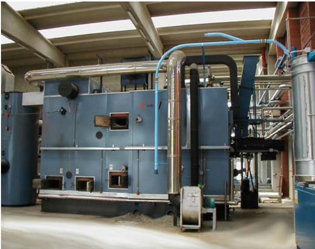
Installazione su centrale termica
